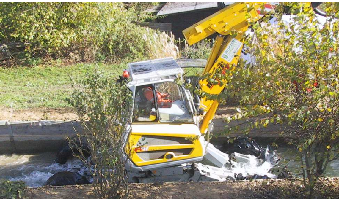
Baggereinsatz im Lochbach am 7.11.2013
