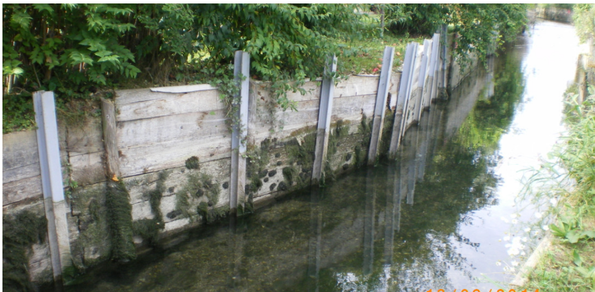
Uferverbau am Lochbach im September 2014
