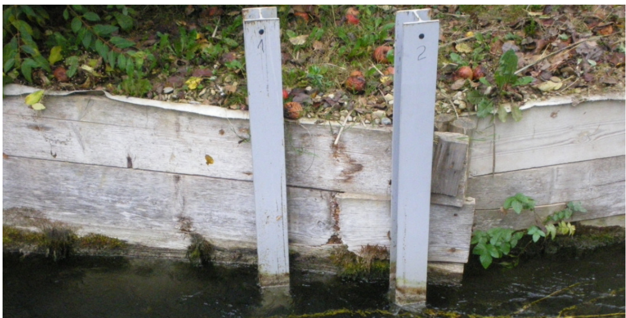
Markierungen schiefer Stahlträgern für Verformungsmessungen
